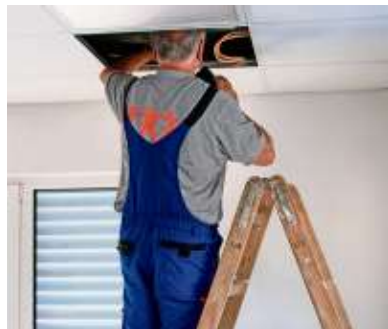
Die Handwerker nehmen abschließende Elektroinstallationen vor.
